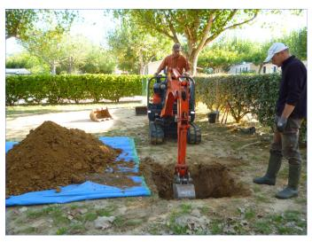
Pour réparer les fuites parfois nous avons recours aux grands moyens. Ce matin nous avons fait appel à une mini-pelle pour creuser à notre place. En effet la fuite et donc le tuyau étaient situés à environ 1 mètre de profondeur. C'est un tuyau d'arrivée d'eau propre pour une borne d'emplacement qui a lâché. Une fois réparé la borne sera de nouveau alimentée en eau.
