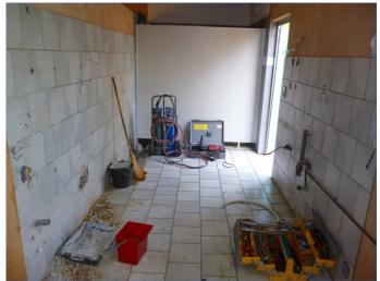
Dès la fermeture du camping nous nous sommes mis au travail aux sanitaires. Apres la nouvelle cabine handicapé un nouvel espace buanderie est à l'œuvre. Nous avons déjà démonté tout l'ancien mobilier et préparé le sol et les murs pour le carreleur. L'électricien et le plombier sont prêt à mettre en place les nouvelles machines et séchoir adaptés aux personnes à mobilité réduite.
