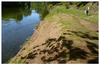
C'est au printemps que l'on peut commencer ces aménagements sans risque une fois que les pluies de l'hiver se calment enfin. Nous avons mis en place une nouvelle technique pour protéger notre berge. Un géotextile vient protéger le bord du terrain solidement arrimé dans le sol par des pieux en bois. Le gazon a ensuite été posé et commence à recouvrir la zone.
