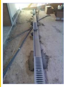
Autre moment technique la pose des caniveaux d'évacuation. Ils doivent être placés au bon endroit pour correspondre avec la pose des cabines. Apres avoir tout bien calculé avec des mètres laser, calés au millimètre prêt!
