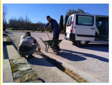
Apres la cabine handicapé, des panneaux spéciaux, des guides et rampes, voici maintenant le chemin pour déficient visuel. C'est un cheminement qui part de notre place de parking jusqu'au marche du bar. Il a fallu pour cela trancher la route sur 20cm de large et sur 20 cm de profondeur.
