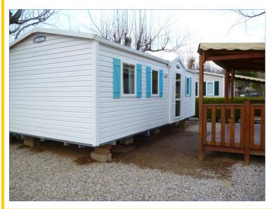
Apres être rendu sur l'emplacement il faut proceder au calage au sol. Et là c'est un petit jeu de vérin, monter d'un coté et descendre de l'autre pour enfin le stabiliser pour qu'il soit de niveau. Pas moins de 8 points de fixation au sol sont nécessaires pour supporter son poids. Au bout d'une après-midi d'efforts le mobil-home est enfin en place, reste la terrasse à replacer et les raccordements, l'opération sera ensuite terminée.
