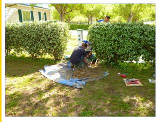
C'est quand on ouvre les vannes que l'on repere les fuites! (proverbe de gerant de camping) C'est bien ce qu'il s'est passé lors de la remise en eau du camping. Une bonne fuite sous une borne. Une endroit pas facile pour réparer. Il a fallu demonter la borne pour acceder au tuyau et colmater la fuite.
