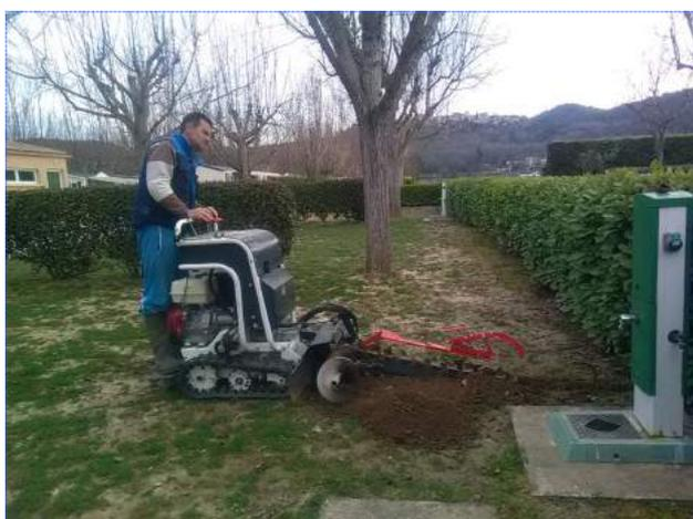
Cet été après une fuite sur une arrivée d'eau de borne et une réparation provisoire nous avons fait passer en aérien le réseau. Maintenant la réparation est effectuée. Location d'une trancheuse pour nous faciliter le travail.
