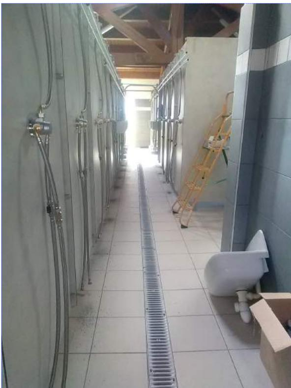
Les plombiers sont aussi à l'œuvre, tout le réseau doit être revu et corrigé. Tout repart à neuf, les anciens tuyaux étaient remplis de sédiments et de bouchons multiples. Autant les changer entièrement.
